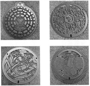
本年度発注範囲の耐用年数越えのマンホールふたの例
