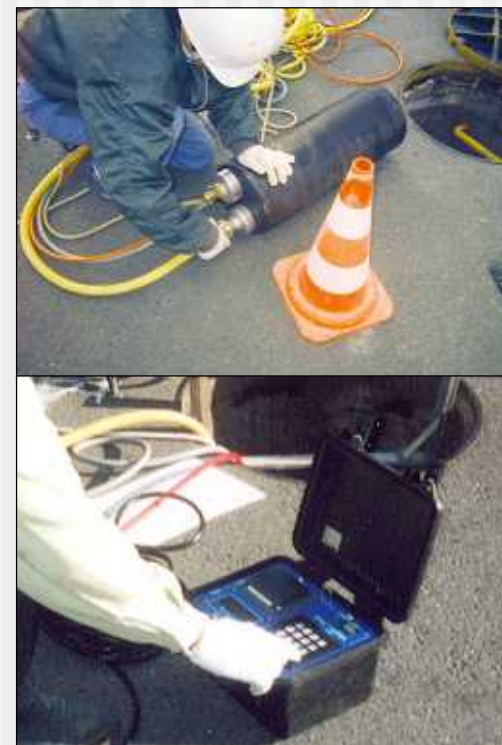
圧気試験状況
