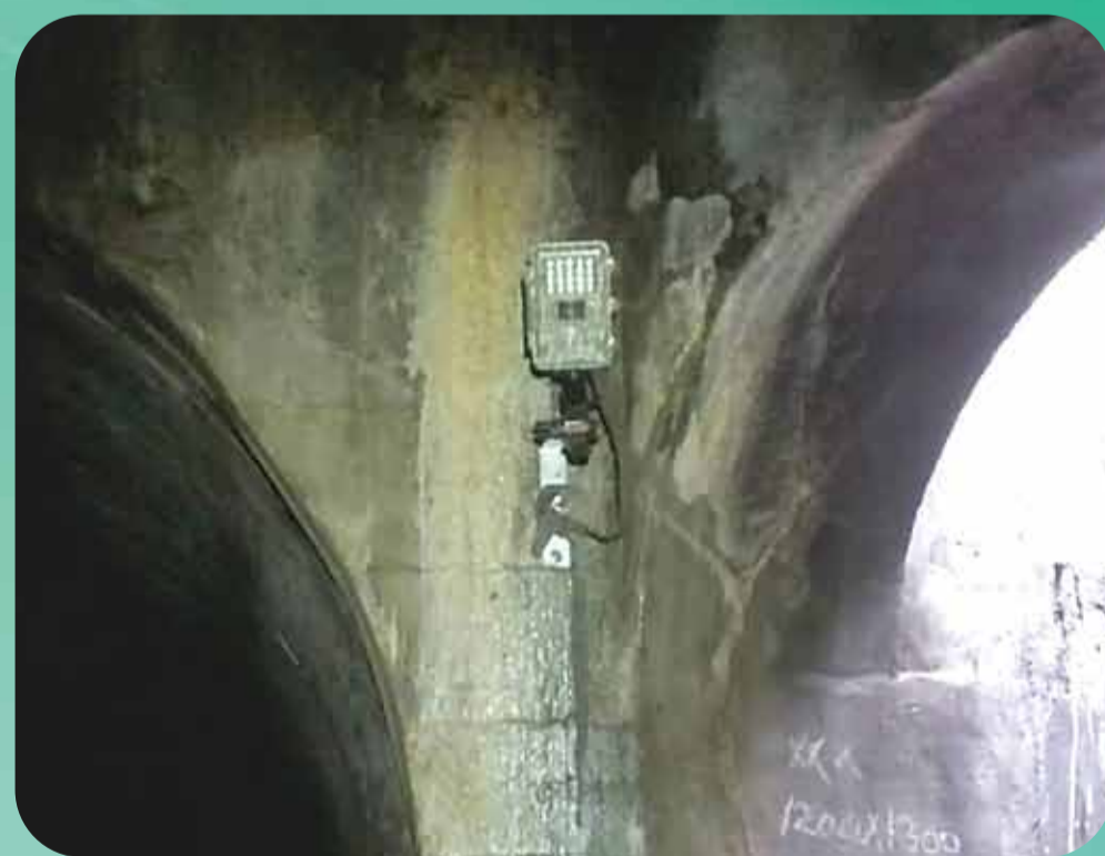
動画カメラ (連続・水位トリガ撮影) スチルカメラ (連続・水位トリガ撮影)
