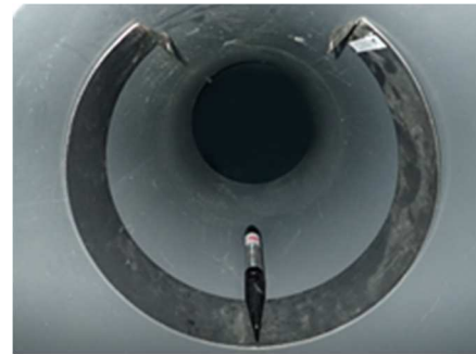
圧力チップによる緊急避難管の越流水位調査
